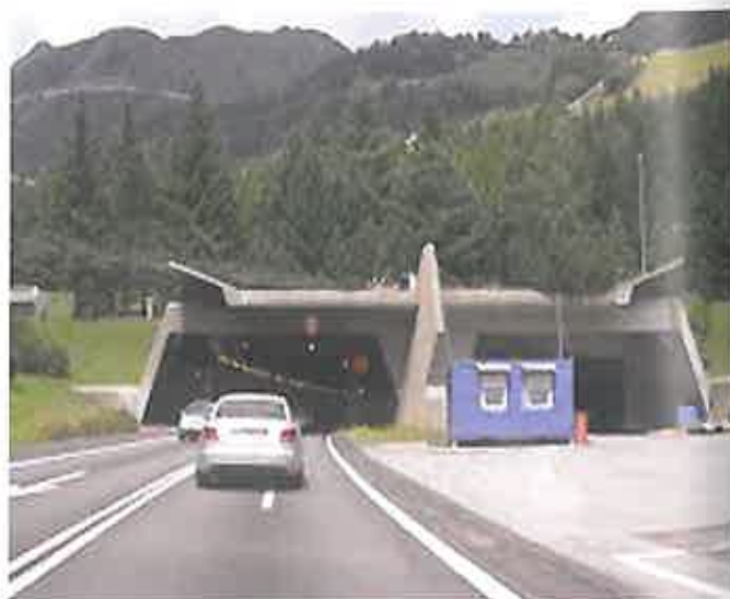
Galleria o Tunnel di San Gottardo
